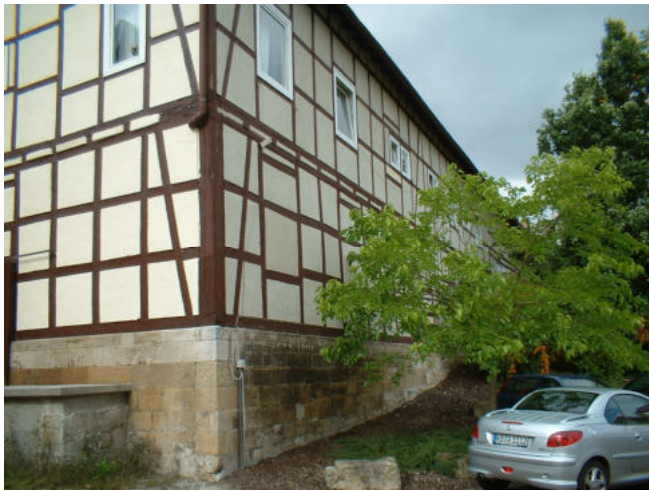
Haus Lengfelder Str. 11 (Seitenansicht)
